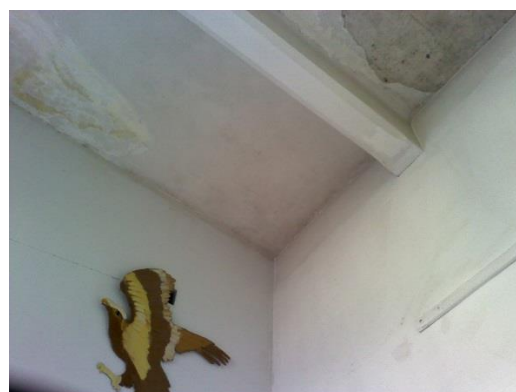
Figura 2.7 – Foto copertura piano S02
